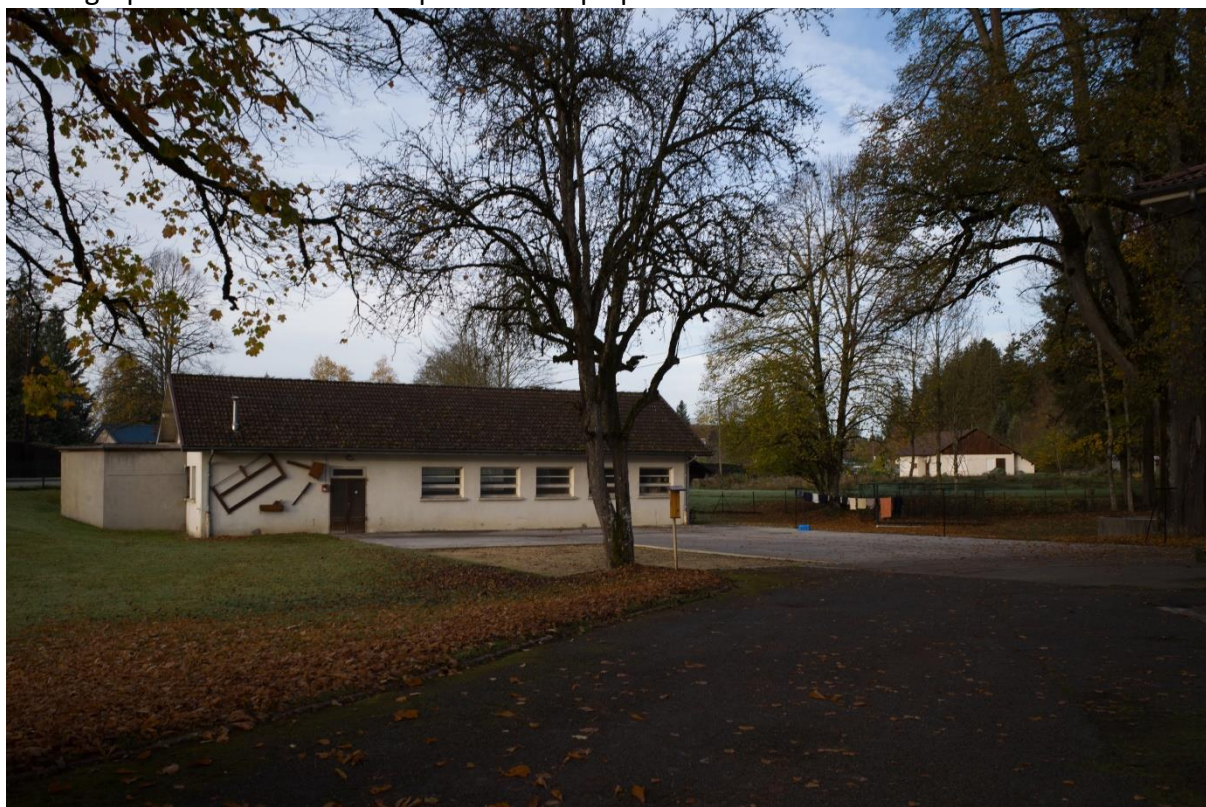
Photographie 15 : Le bâtiment qui sera occupé par le service sur le site de Maïche
