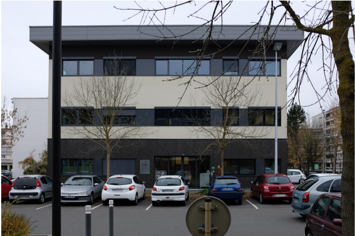
Photographie 1 : Le bâtiment de Montbéliard :
